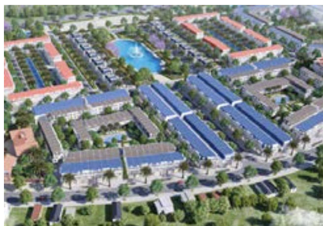
Các công trình thiết kế, thi công bể bơi
