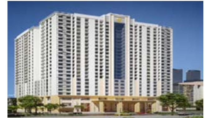
PHOENIX TOWER Ngã 6 Lý Thái Tổ, Phường Đại Phúc, Tỉnh Bắc Ninh
