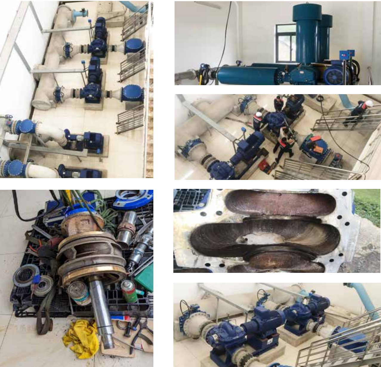
BẢO TRÌ HỆ THỐNG BƠM CỖ LỚN NHÀ MÁY NƯỚC CẤP CHO LỘC HOÁ DẦU NGHỊ SƠN, THANH HOÁ
