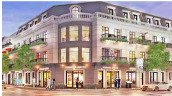
XỬ LÝ NƯỚC THẢI DRAGON HILL CITY 300M3 - BÃI CHÁY, QUẢNG NINH
